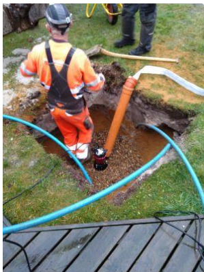
En sugestav monteres i ca. 1 m dybde og sænker vandstanden via en pumpe, når grunden oversvømmes.
