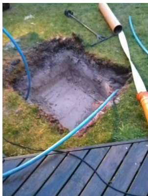
En sugestav monteres i ca. 1 m dybde og sænker vandstanden via en pumpe, når grunden oversvømmes.
