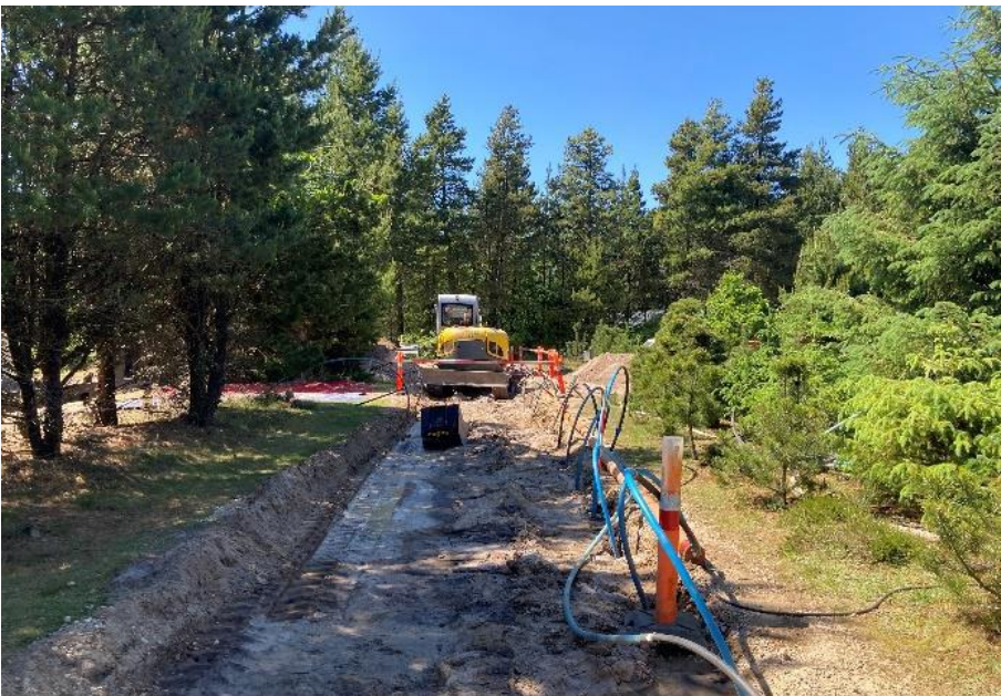
Trafikhåndtering og graveområde i forbindelse med udvidelsen af grundvandssænkningen på Kirkeflod 36-58.
